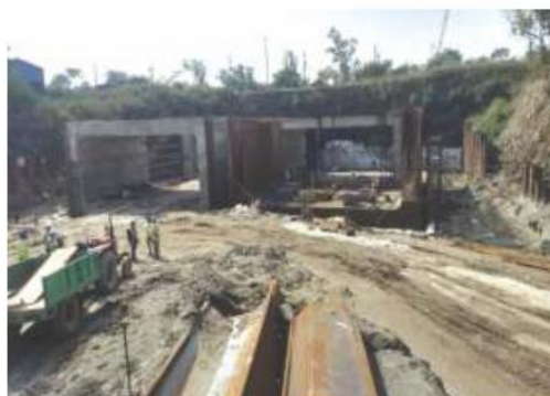
प्रगति मैदान पर मृदा कीलबंदी के साथ बॉक्स जैकिंग द्वारा रेल अंडरपास का निर्माण
